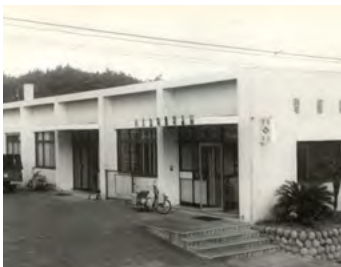
中之郷簡易水道工事完成
