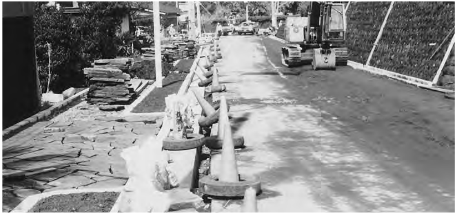
道路を広げる工事
