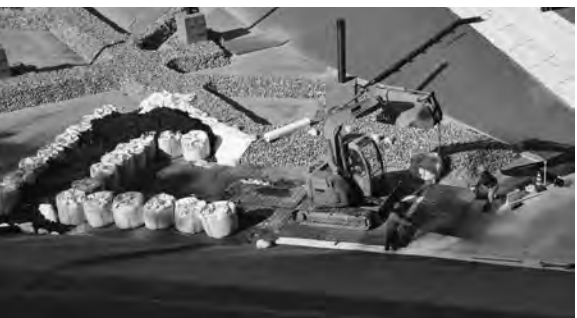
みずみやまさいしゅうしょぶんじょう 水海山最終処分場での作業
