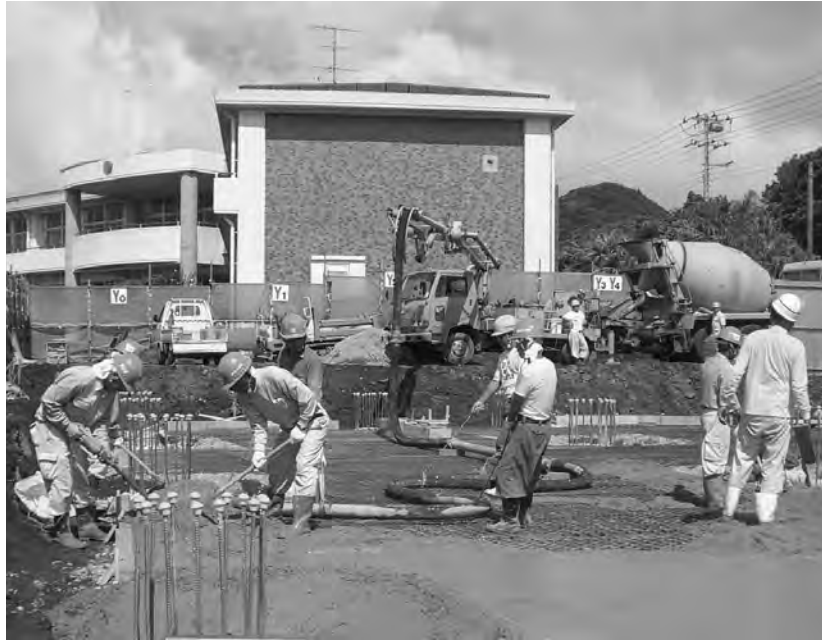
三原小学校の工事
