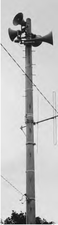
防 ぼう さい行政無線 ぎょうせいむせん の鉄塔 てつたう
