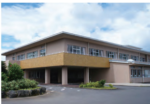
①㉓ 町立八丈病院 (三根・中道)
