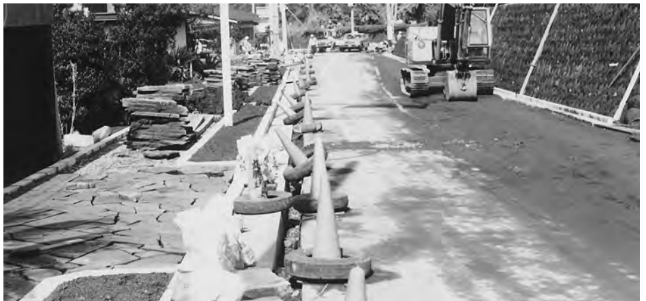
道路を広げる工事
