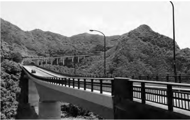
横間道路（平成6年4月に完成）
