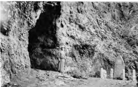
大正13年頃の大坂トンネル（車が通れるようになった）
