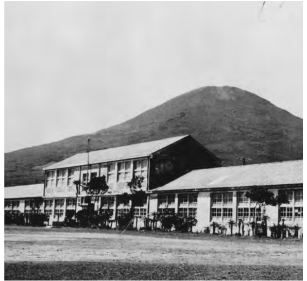
旧富士中学校 (島で初めてのブロック建築)
