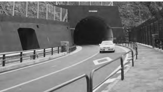
今の大坂トンネル（令和2年）
