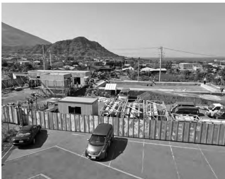
三根小学校のプール工事
