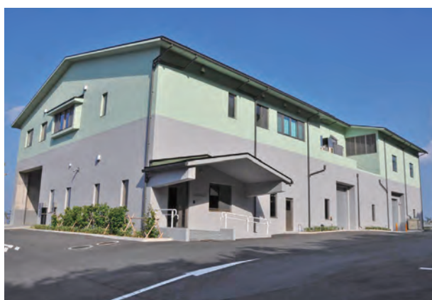
①㉒ 汚泥再生処理センター (大賀郷・永郷)
