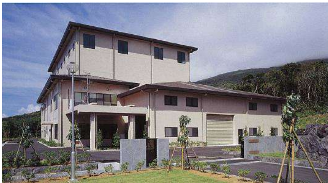
八丈町クリーンセンター
