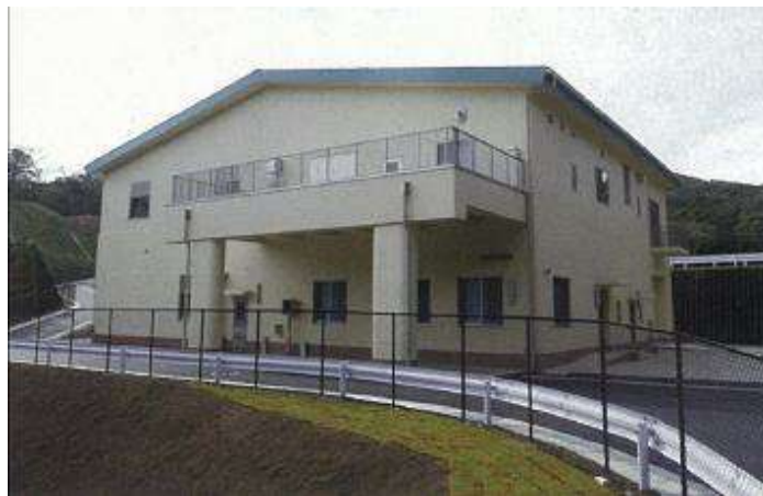
浸出水処理施設
